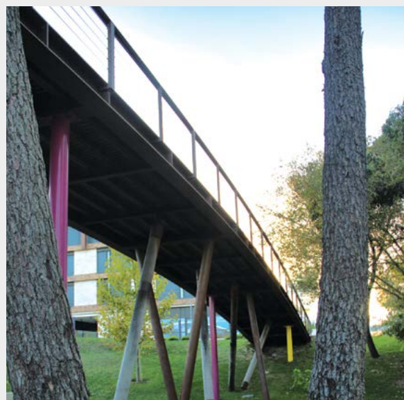
// PASSERELLE PIETONNE - Tróia - Portugal
