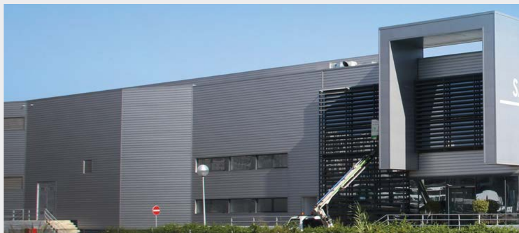
// BÂTIMENT COMMERCIAL - Póvoa de Sta Iria - Portugal
