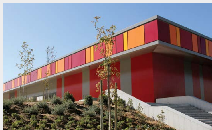
// BÂTIMENT COMMERCIAL - Moscavide - Portugal
