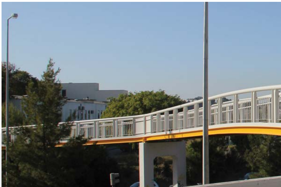
// PASSERELLE PIETONNE - Almada - Portugal
