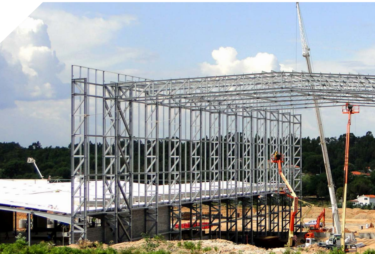
// BÂTIMENT INDUSTRIEL - Tábua - Portugal
